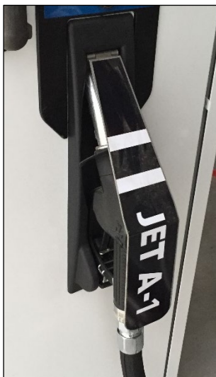
Abbildung 1 Beispiel einer Schutzabdeckung mit der Beschriftung Jet A-1 über der Zapfpistole
