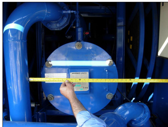
Abbildung 3 Beispiel, wo Umrüstung aufgrund der gegebenen Platzverhältnisse nicht möglich ist [AFF 2018, EI / JIG, End of the Filter Monitor]
