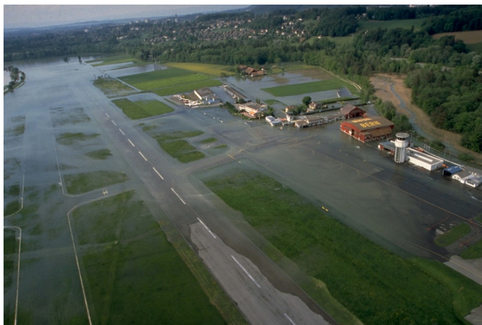
Bild 2: Aufgrund des dichten Gewässernetzes sind mehrere Infrastrukturen für die Luftfahrt einem Überflutungsrisiko ausgesetzt (hier der Flughafen Bern-Belp im Jahr 1999). (Foto: VBS/Schweizer Luftwaffe)
