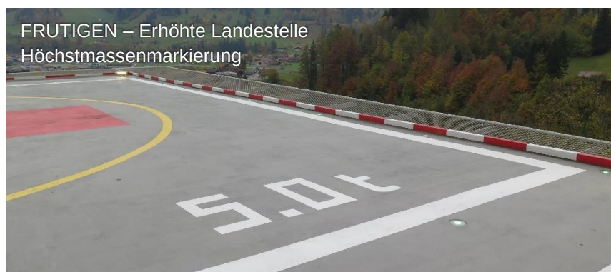
Abbildung 13 Höchstmassenmarkierung gerundet auf 100 kg
