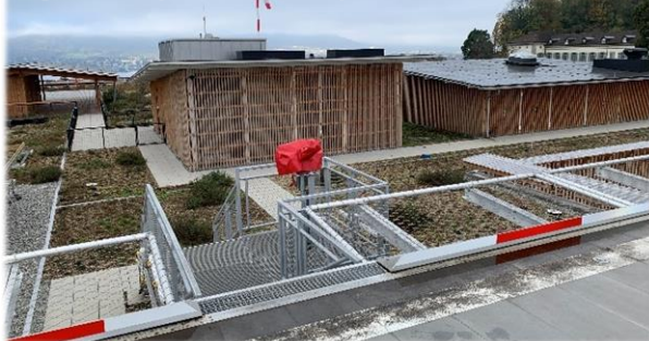
ZÜRICH Kinderspital – Erhöhte Landestelle System A (Löschmonitor)
