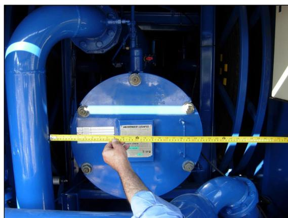
**Abbildung 3** Beispiel, wo Umrüstung aufgrund der gegebenen Platzverhältnisse nicht möglich ist [AFF<sup>7</sup> 2018, EI / JIG, End of the Filter Monitor]
