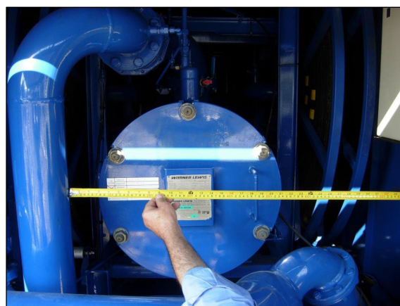
Figure 3 Exemple d'une conversion impossible en raison du manque de place [AFF 2018, EI / JIG, End of the Filter Monitor]
