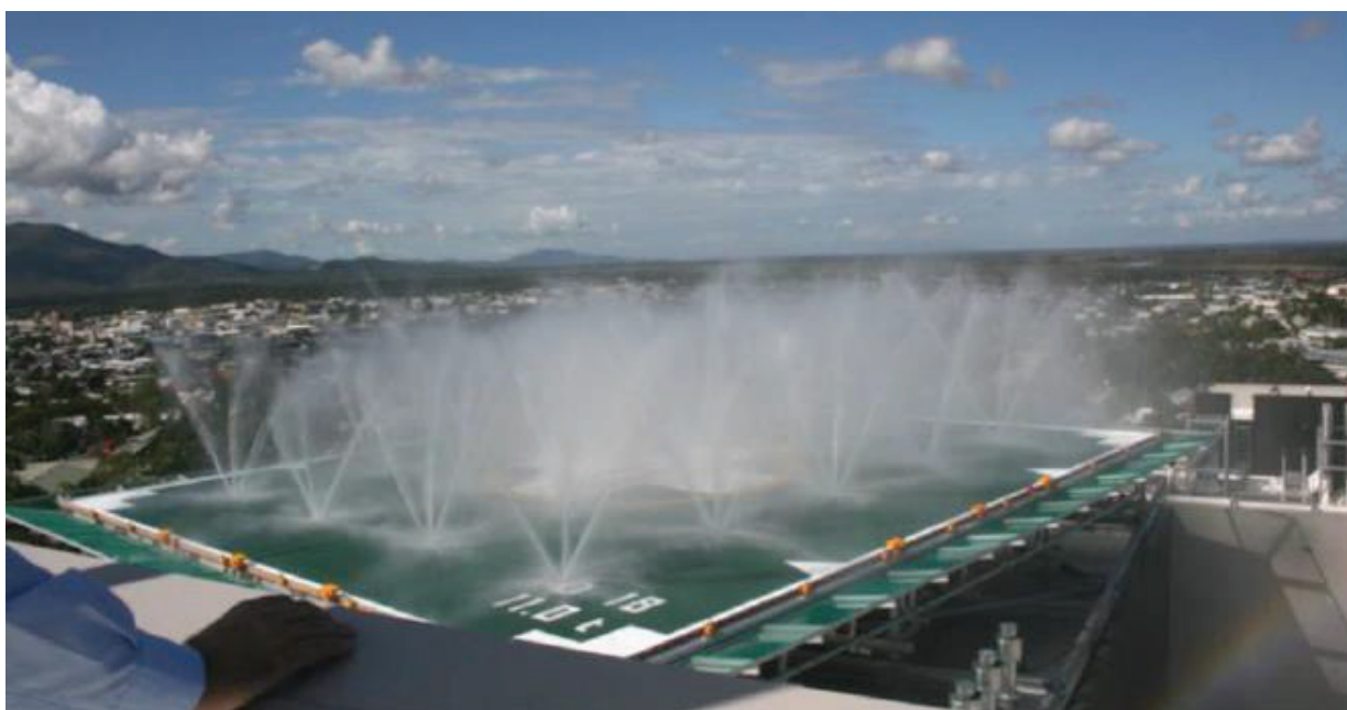
Figure II-6-8. Un DIFFS à l'eau sur une hélistation avec une surface anti-feu passive
