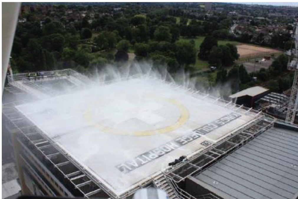
Figure II-6-5. Un DIFFS à mousse sur une surface à plaque solide à une hélistation en terrasse
