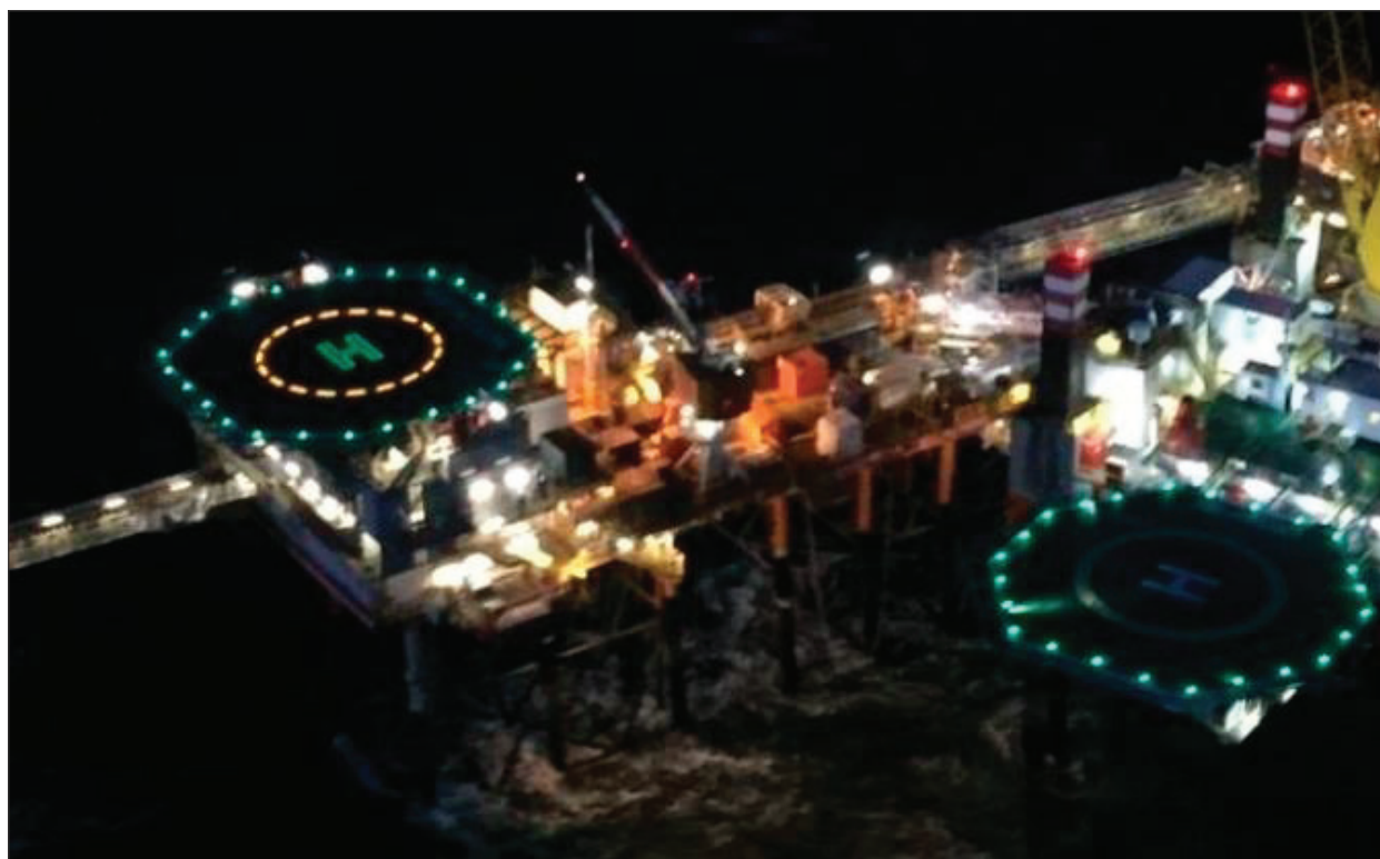
Figure I-5-13. Plate-forme fixe (à gauche) avec balises de marque TD/PM et balises de marque distinctive d'hélistation. Unité mobile de forage en mer (à droite) avec système d'éclairage par projecteurs montés sur le pont
