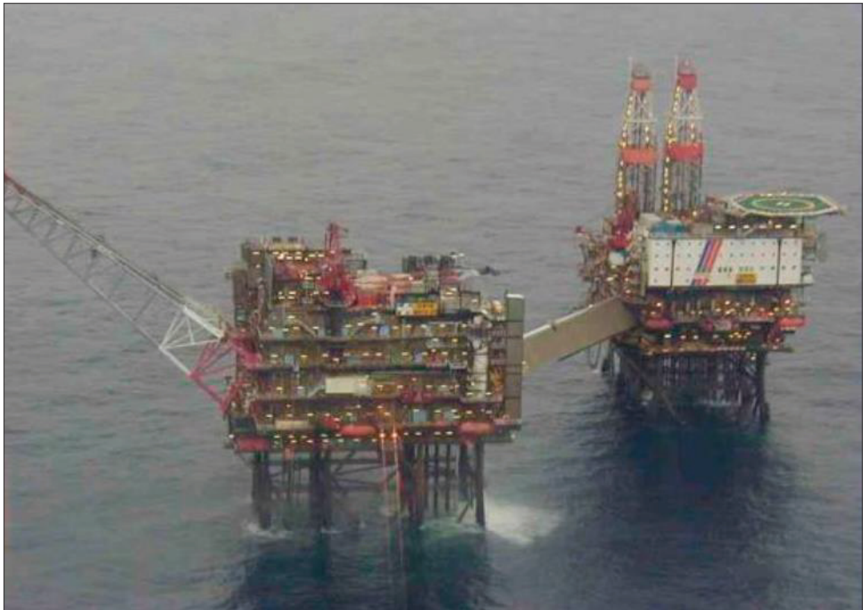
Figure I-1-1. Plate-forme fixe avec hélistation au-dessus des hébergements, reliée à une plate-forme de production par un pont
