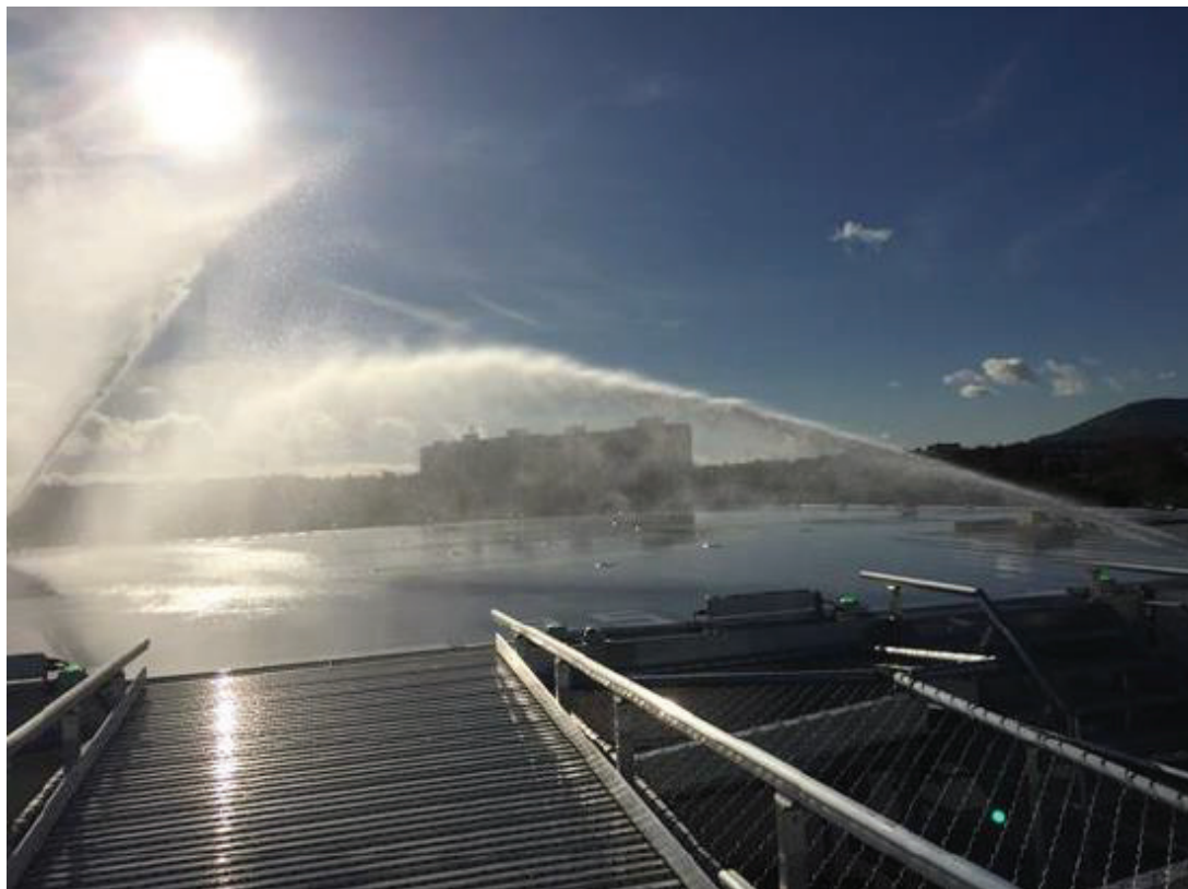
Figure II-6-3. Application en jet rectiligne utilisant un système fixe de lances à mousse (FMS)
